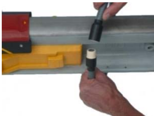
2. Pase un cabo de C-sensor debajo de carril
